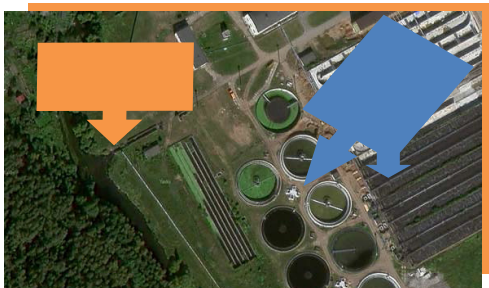
Площадка блока доочистки и обеззараживания очищенных стоков на сбросе в водоём реки Увудь на очистных сооружениях канализации в г. Иваново
