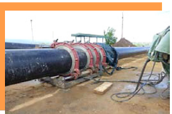
Строительство сетей канализации в пос. Скуратовский г. Тулы
