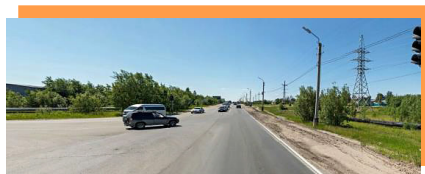
Тепловые сети в промышленной зоне в г. Нефтеюганске: слева новый участок, справа – старый участок трубопровода
