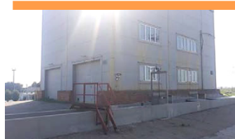
Новое здание решёток (объект механической очистки стоков) биологических очистных сооружений в г. Волжском
