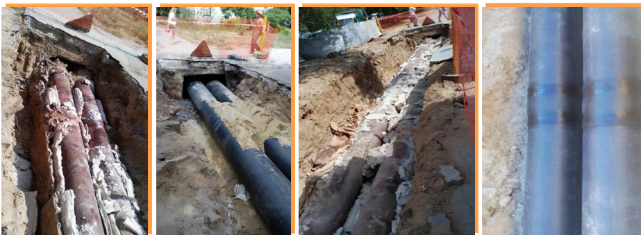
Замена труб тепломатриалы № 8 в г. Волжском (2017 г.)
