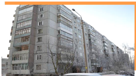
Типовой девятиэтажный многоквартирный дом серии 1-335-АК, расположенный по адресу г. Архангельск, ул. Касаткиной, 5/1, на основании обследования которого готовились типовые рекомендации по повышению энергетической эффективности домов данной серии
