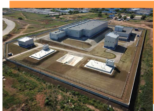
Площадка очистных сооружений водопровода Южно-Уральского водозабора в г. Оренбурге
