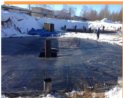
Строительство резервуара сгустителя осадка на очистной водопроводной станции «Заовражная» в г. Чебоксары, ноябрь 2013 года
