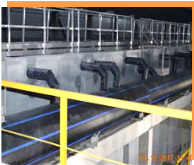
Установка сорбционной обработки воды порошкообразным активированным углем на сооружениях водоподготовки в г. Череповце
