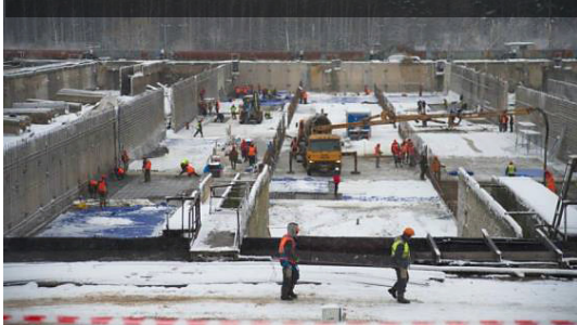
Аэротенки биологической очистки очистных сооружений г. Иваново в процессе работ по реконструкции
