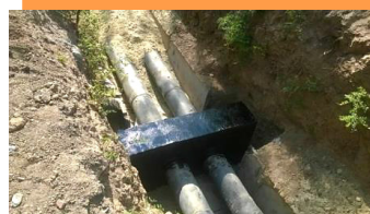
Капитальный ремонт участка теплосети в 18 микрорайоне г. Волжского (2018 г.)
