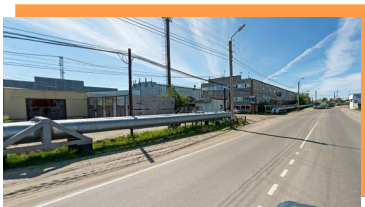
Прокладка тепловых сетей в промышленной зоне в г. Нефтеюганске: надземная на опорах и подземная в местах пересечения транспортных путей
