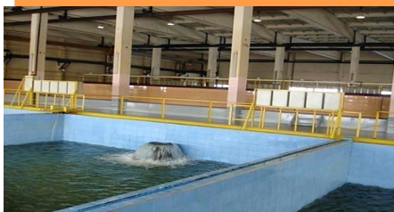
Бассейны фильтрации воды на скорых фильтрах на сооружениях водоподготовки в г. Череповце
