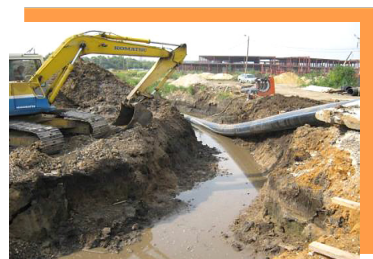
Строительство сетей водоснабжения в пос. Скуратовский г. Тулы
