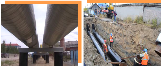
Проведение работ по реконструкции тепловых сетей в г. Нефтеюганске
